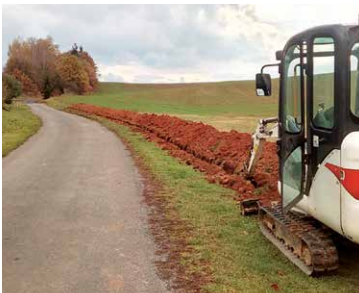
V listopadu 2016 byly zahájeny práce na rozšíření sítě veřejného osvětlení ve vybraných lokalitách
