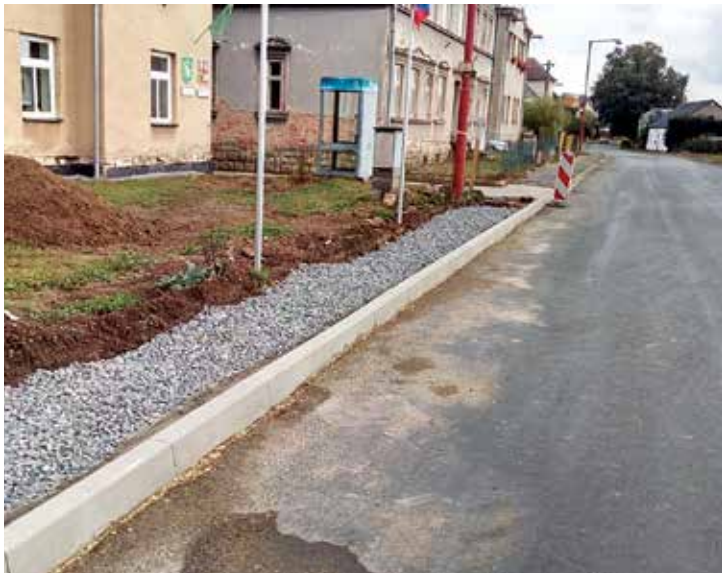
Fotografie z průběhu oprav chodníku v úseku u obecního úřadu v Kunčíně
