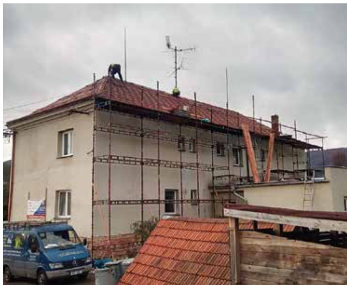
Oprava střechy na obecní budově v Nové Vsi čp. 43
