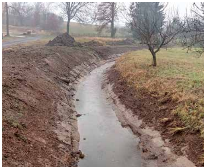
V listopadu 2016 začaly práce na čištění koryta Kunčického potoka
