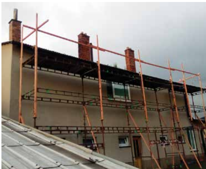
Oprava střechy na obecní budově Nová Ves čp. 37
