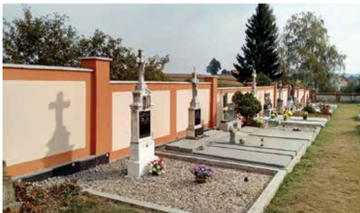
Nově vybudovaná hřbitovní zeď v Kunčíně, obec získala dotace od MZe ČR
